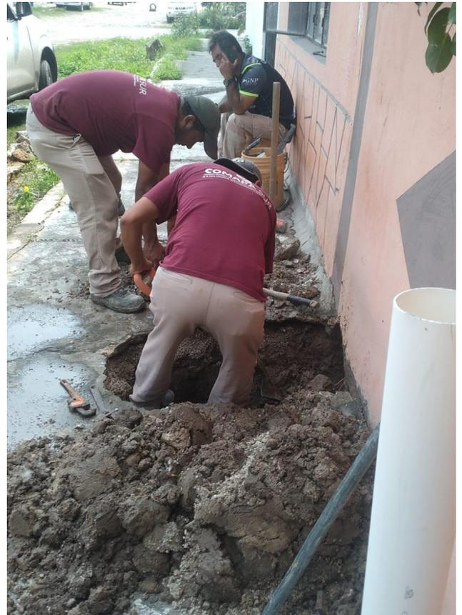
**IMAGEN: REPARACION DE FUGA DE AGUA POTABLE**
